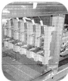
PARTICOLARE DEL VANO DI ATTESTAZIONE CAVI DC.
